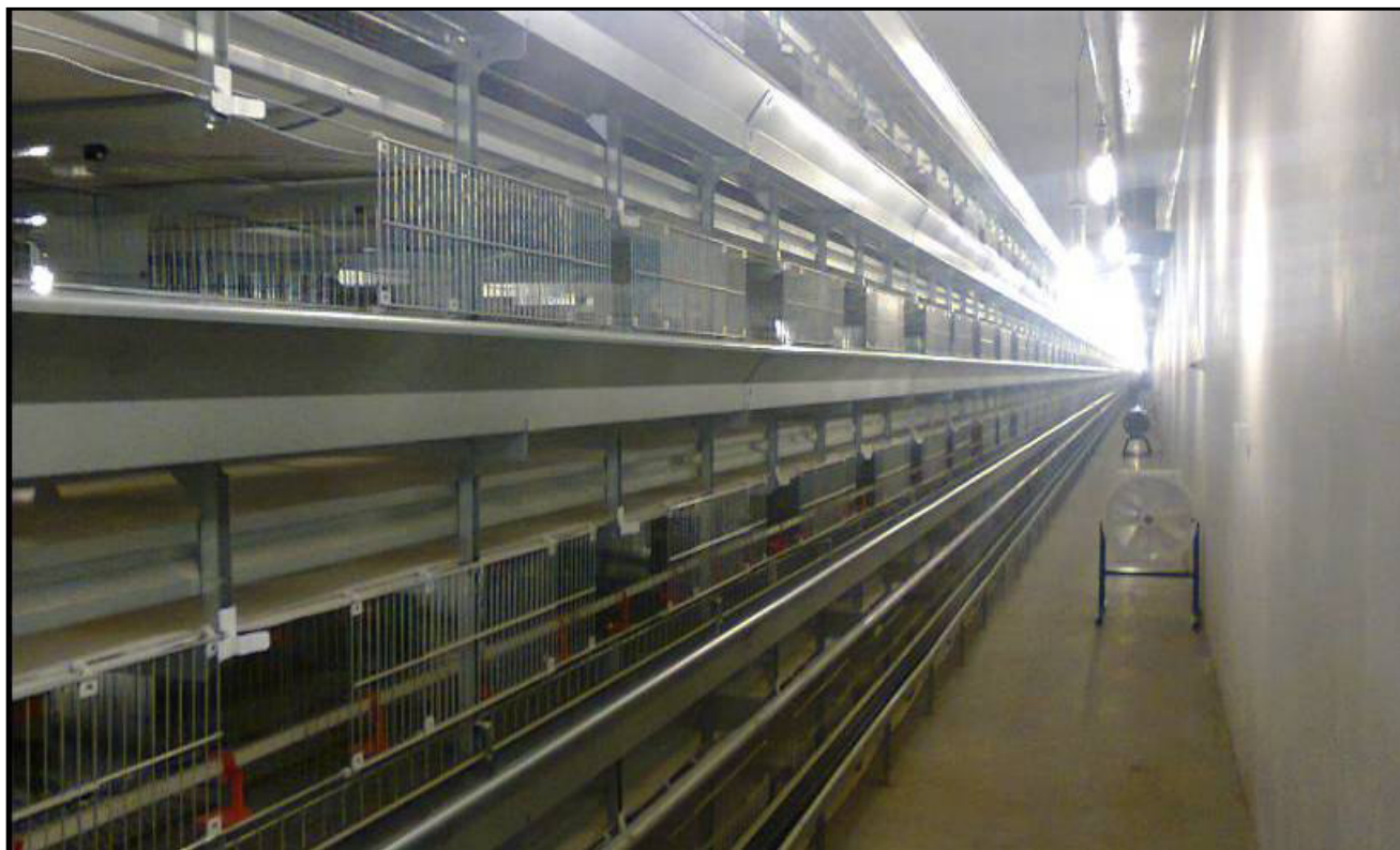
Slika 10. Unutrašnjost izgled živinarnika
