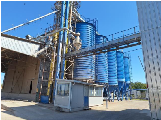
Slika 7 - Rad predmetnog objekta - silos i mešaona stočne hrane (17 silos čelija za smeštaj žitarica i 5 silos čelija za koncetrat)
