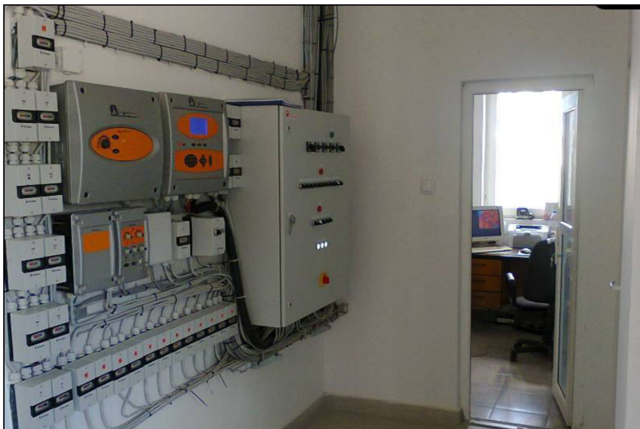
Slika 13. Sistem za automatsku regulaciju svih procesa u živinarniku
